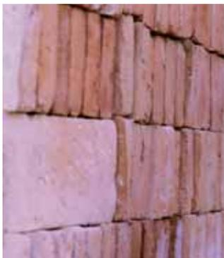
**El ladrillo caravista perforado** se obtiene mediante un proceso de extrusión de la arcilla a través de una boquilla. Es un ladrillo con perforaciones en la tabla de volumen superior al 10 %, quedando asegurada la resistencia y la estanqueidad, al penetrar el mortero en las perforaciones y conseguir una adherencia perfecta entre ambos materiales.
