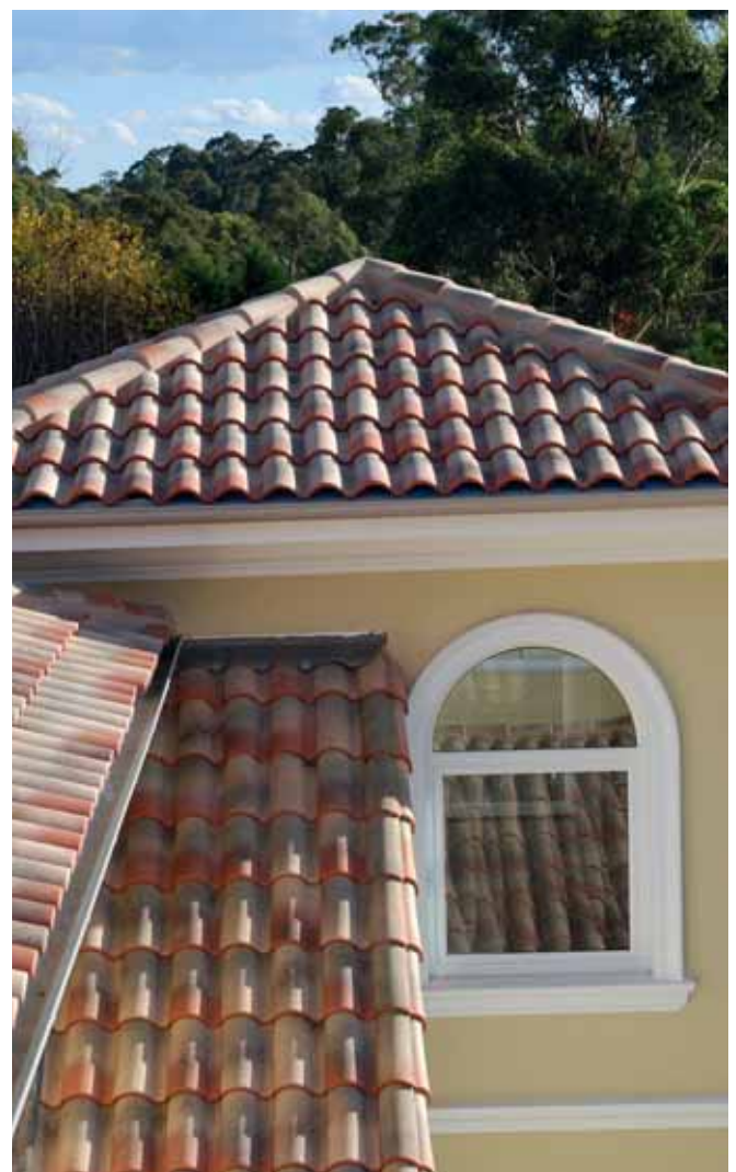
Instalación realizada en Australia.
